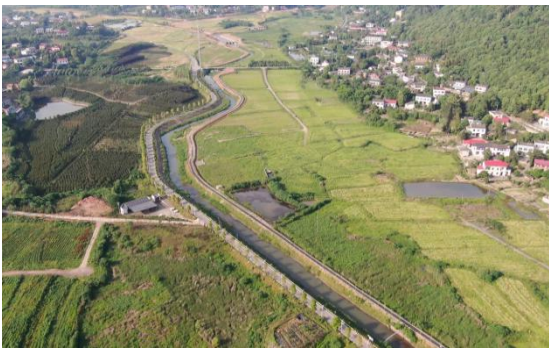
图 4.3-11 沟渠+库塘景观(K5+400-K6 附近)
